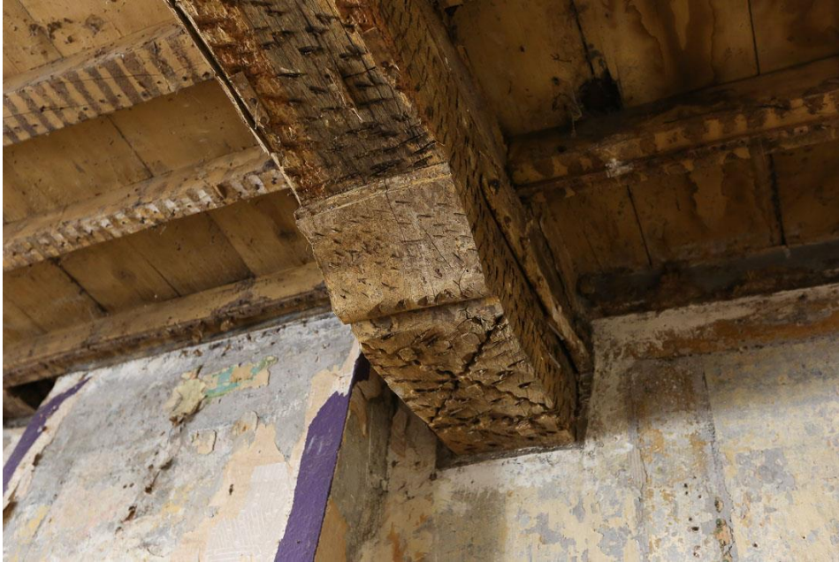
Detail sleutelstuk, versiert middels guts en beitel. Foto: Ton Desar, Gemeente Venlo
